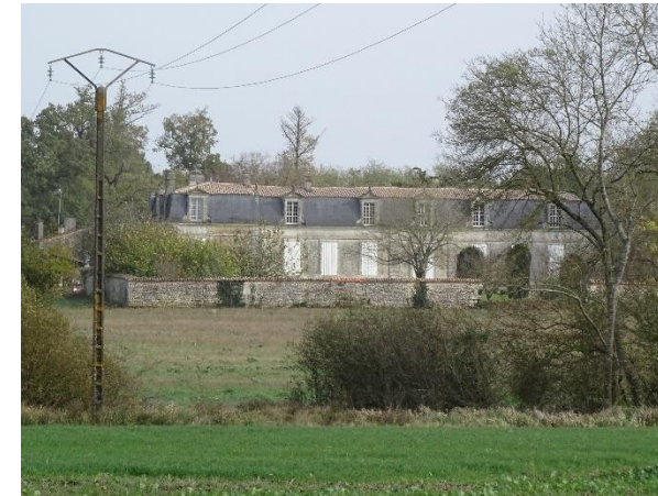
Figure 56. « Logis de Vallade »
