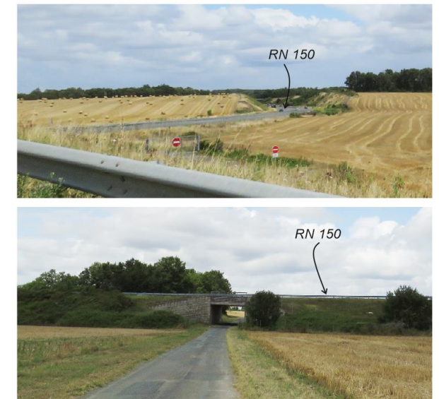
Figure 52. La RN 150 : zone en déblai (photographie du haut) et en remblai (photographie du bas)
